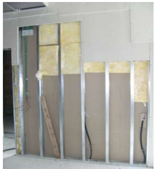
Aplicație internă, peretele unei săli de baie pentru placare cu plăci din piatră naturală București, proprietate privată Proiectant: ZIP Studio Anteprenor: Arbet
